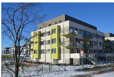
Nové Chabry – dokončené viladomy C
